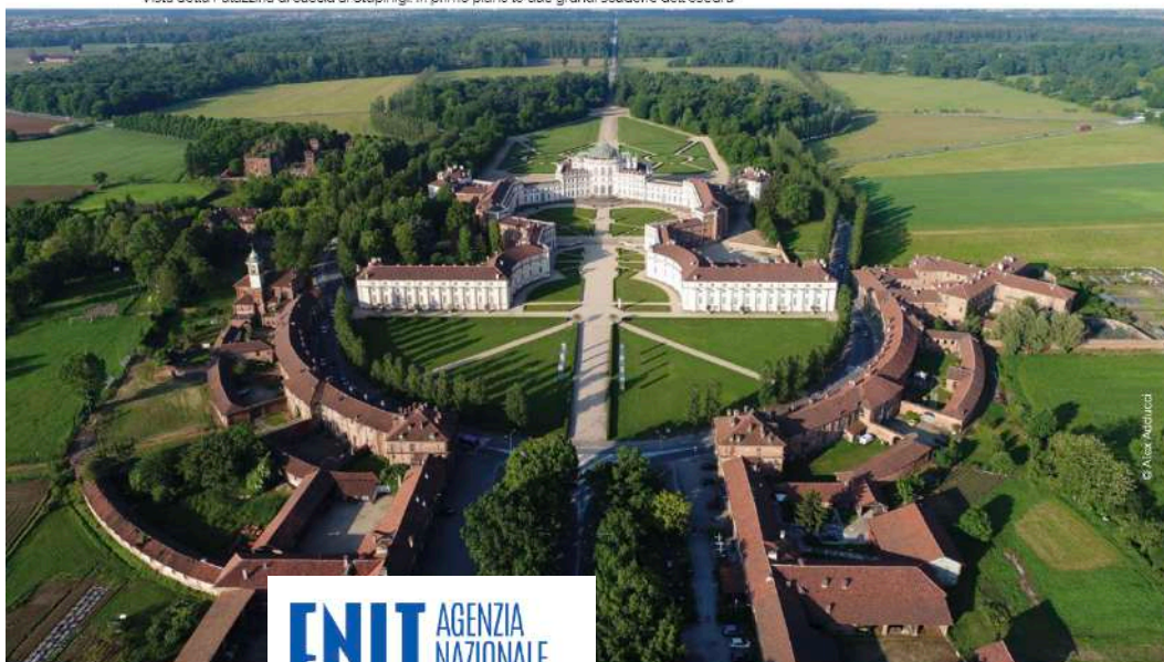
Vista della Palazzina di caccia di Stupinigi. In primo piano le due grandi scuderie dell'edera
